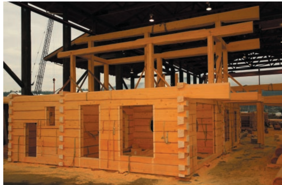
Blockbau mit Rahmen-Obergeschoss und Pfettendach
